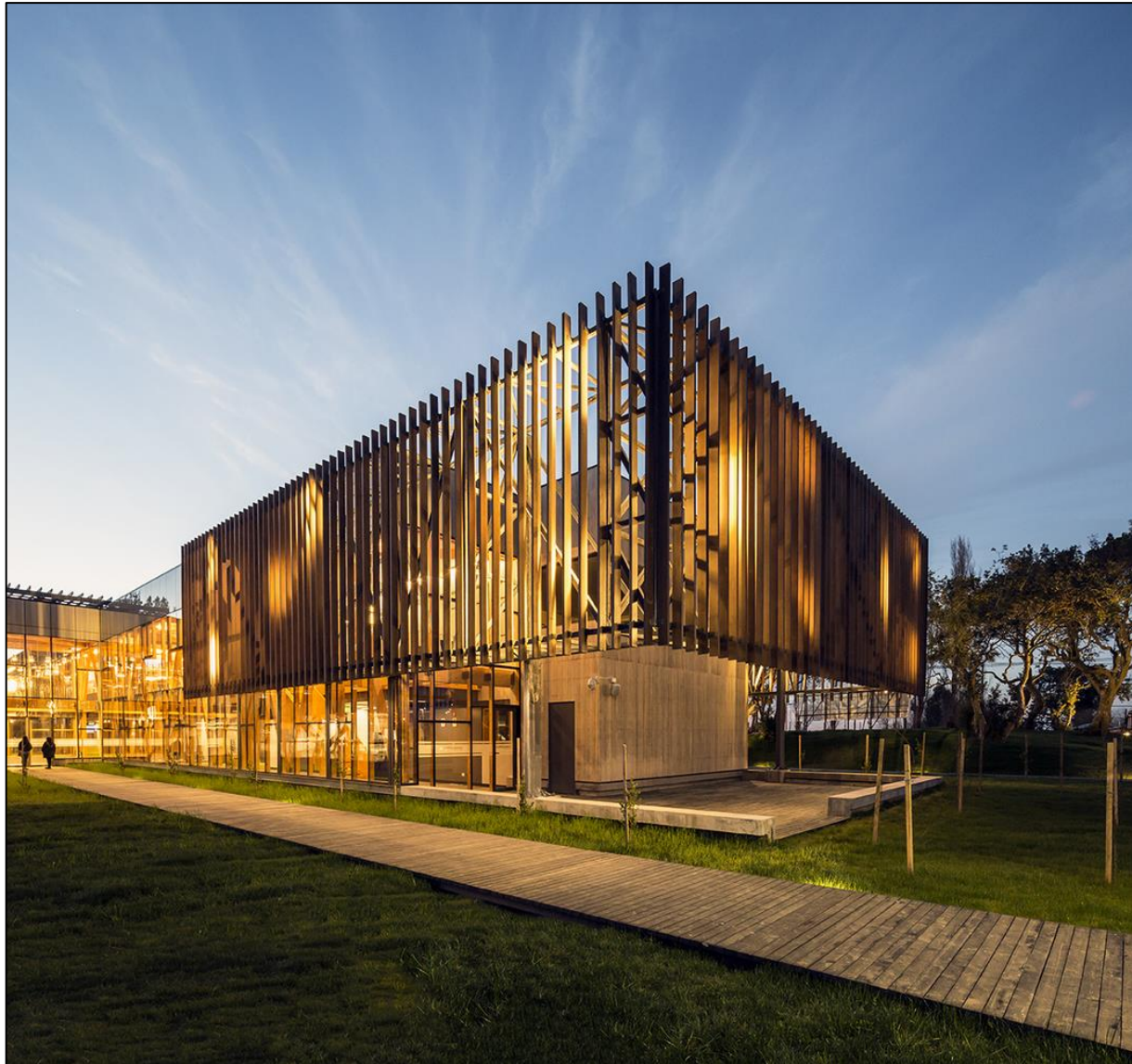
Figura 71: Fotografía acceso principal CFT ARAUCO DUOCUC / GDN Architects.
