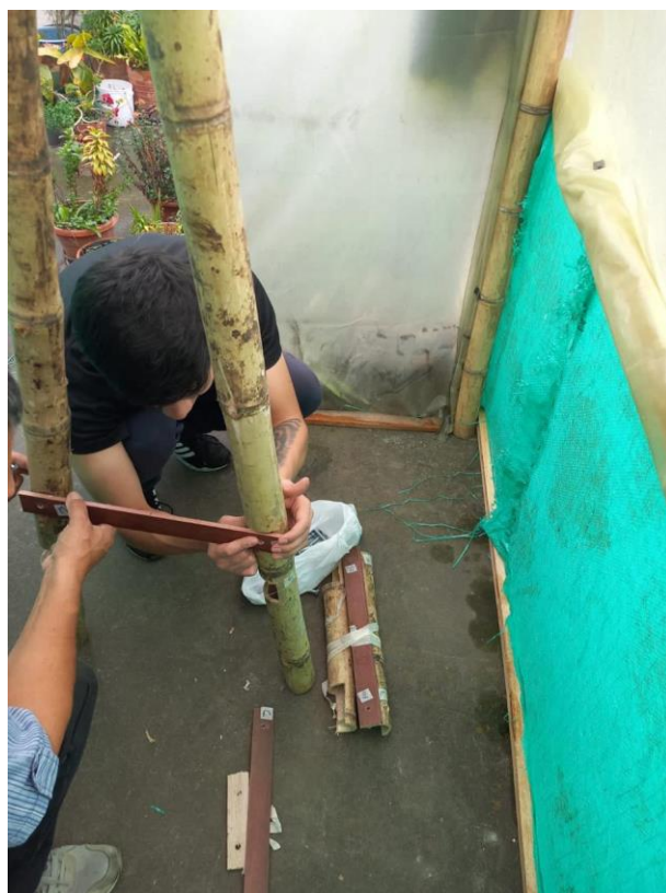
Figura 19. Armado de la estructura de la cabina dos
