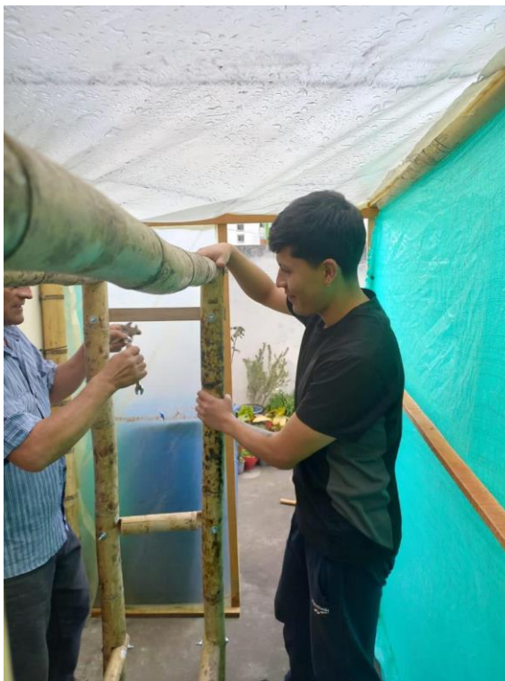
Figura 18. Armado de la estructura para la cabina uno
