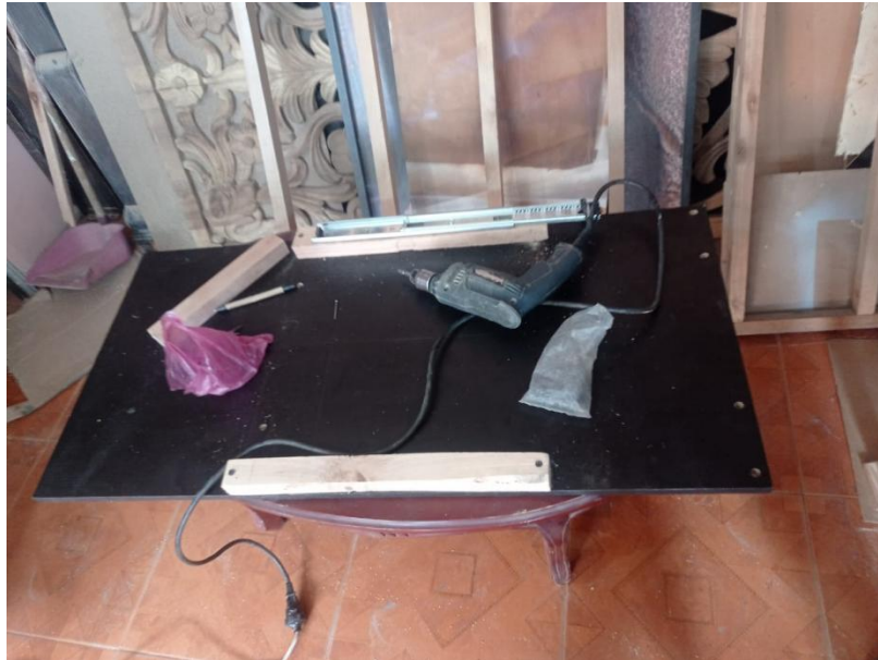
Figura 11. Mesa de soporte colocando los rieles.
