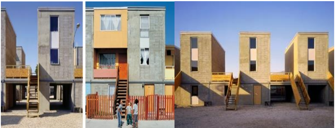
Figura 4. Viviendas quinta Monroy, arquitecto chileno Alejandro Aravena
