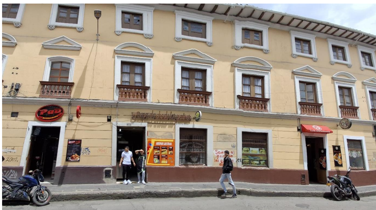
Fachada frontal casa Pueyo de Val
