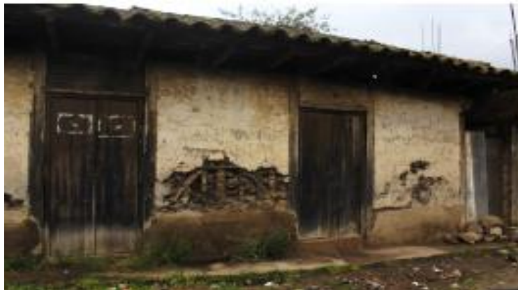
Figura 13. Vivienda en técnica constructiva nativa, Municipio de Túquerres.
