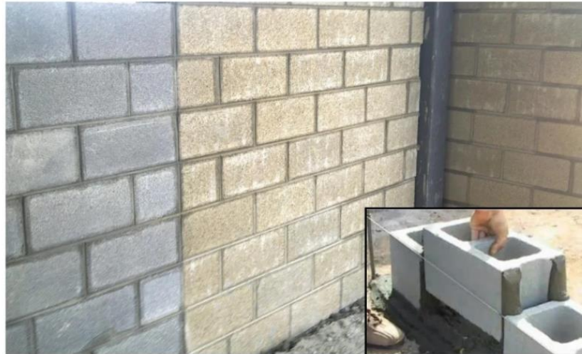
Figura 13. Mampostería en bloque.
