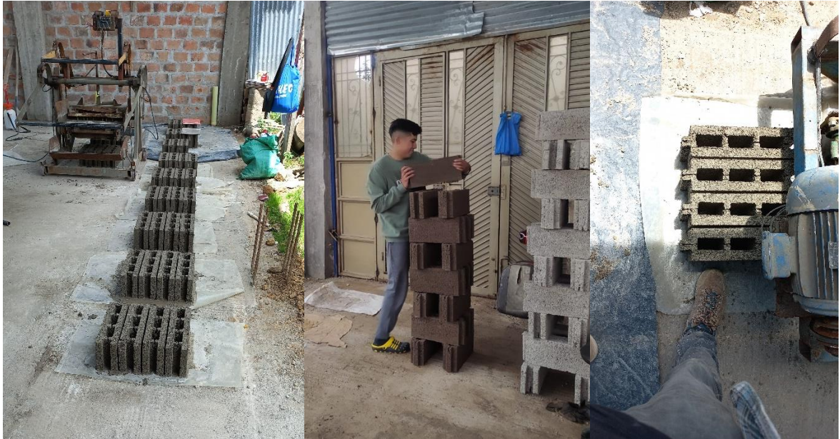
Figura 52. Área de producción mampostería.
