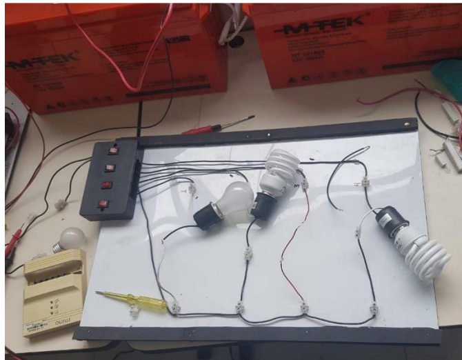
Figura 35. Montaje de los Sistemas Fotovoltaicos
