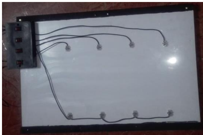
Figura 34. Tablero de pruebas sin cargas
