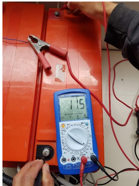
Figura 40. Condición final de la batería 11.5 v
