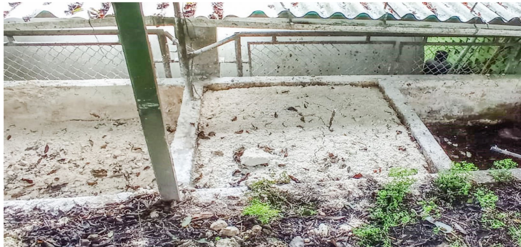
Figura 6 Pilas de estabilización de lodos.
