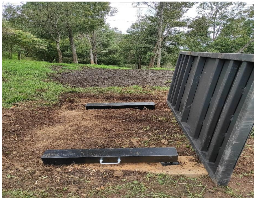
Figura 45. Implementación estructura y barras ganaderas en campo abierto.
