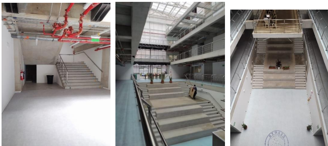
Figura 13 Instalaciones interior bloque de aulas
