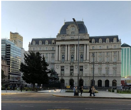
Figura 30. Fachada principal Centro cultural Kirchner
