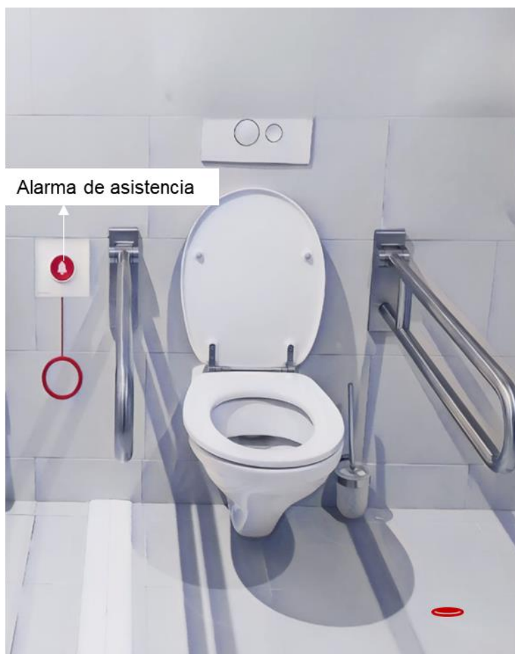
Figura 44 Localización de alarma de asistencia en baño para movilidad reducida
