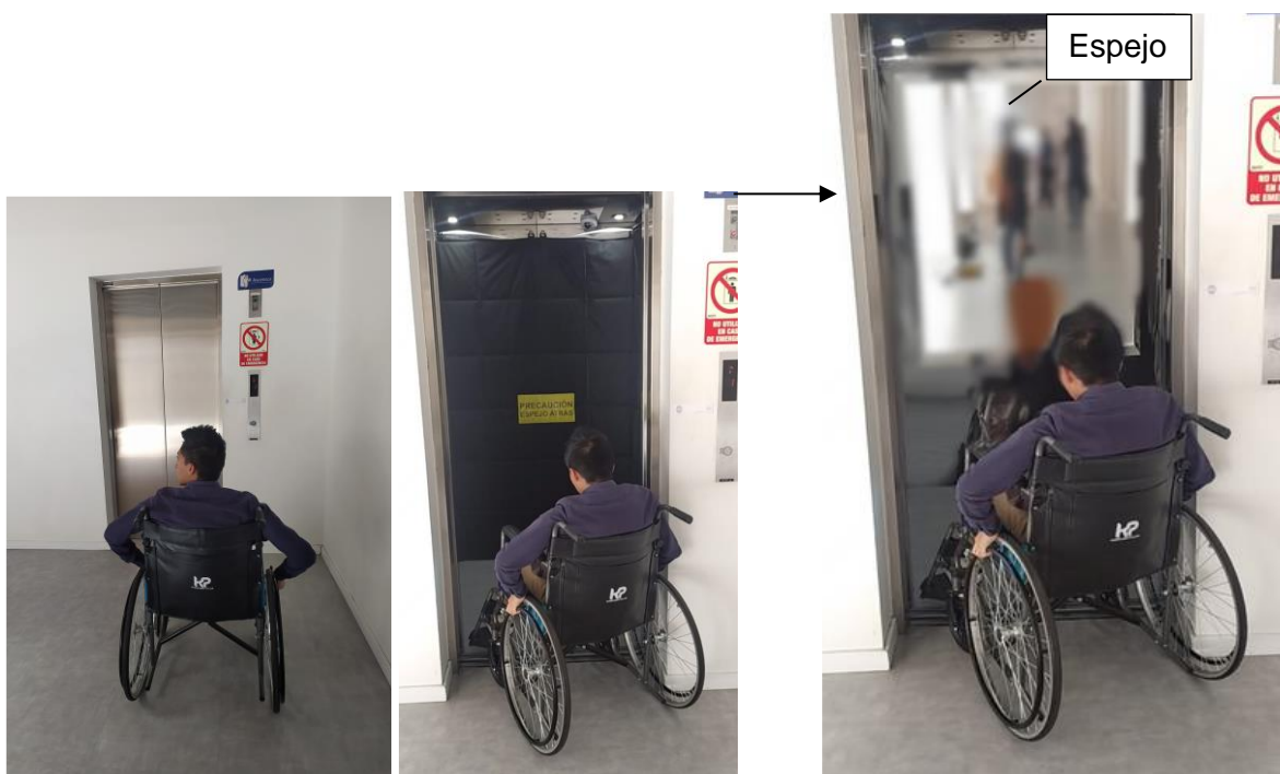
Figura 43 Ascensor Bloque de aulas
