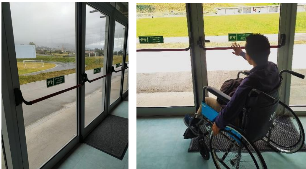
Figura 39 Situación puertas existentes (salidas de emergencia MUSD)
