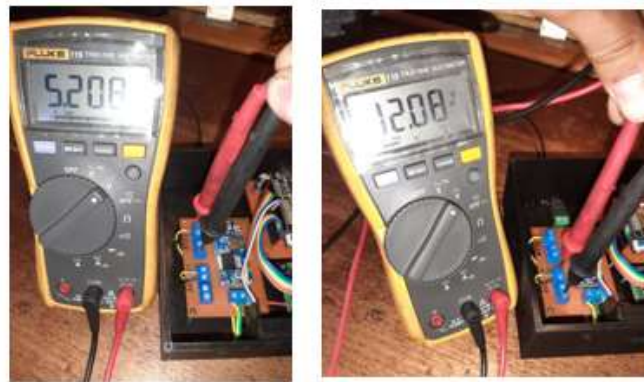
Figura 46. Verificación de voltajes de 5.2V y 12V LM2596
