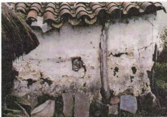
Figura 10. Sistema estructural de la vivienda tradicional indígena en madera rolliza.
