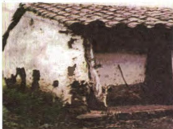
Figura 11. Muro de tapia pisada utilizado en la vivienda tradicional indígena.
