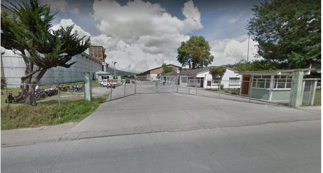
Figura 40. Equipamiento de seguridad – Estación de policía sur.
