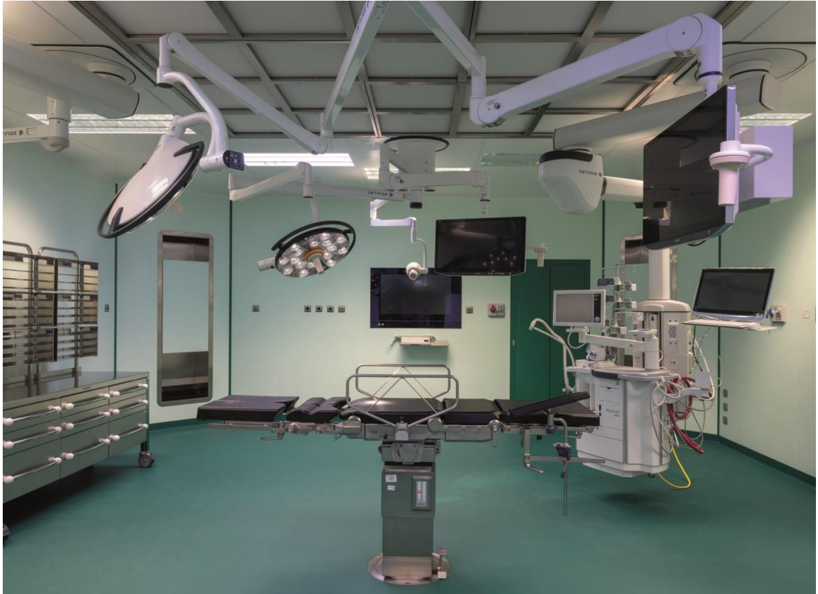
Figura 31. Quirófanos del Hospital San Raffaele
