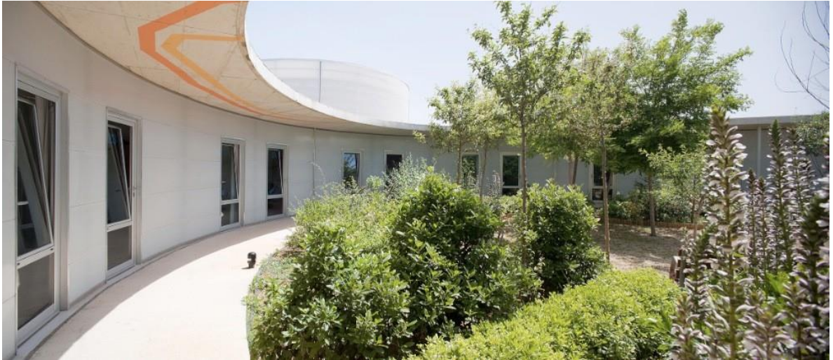
Figura 15. Iluminación interna natural Centro Sociosanitario Geriátrico – Santa Rita.
