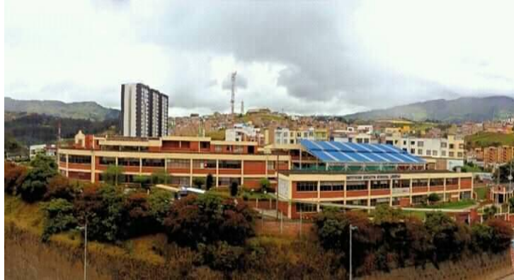
Figura 48. Vista aérea de Equipamiento educativo, colegio Libertad.
