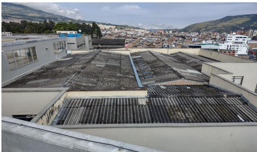
Figura 21. Cubierta Edificio Holanda Italia.
