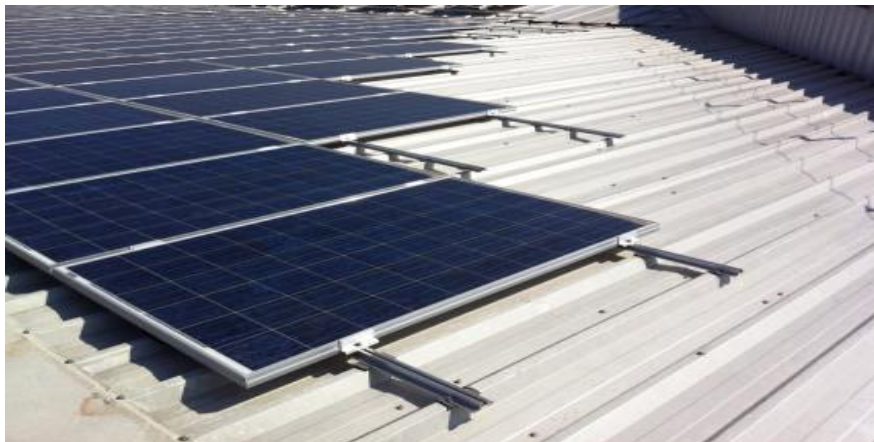
Figura 24. Estructura para paneles solares Fuente:(Solarstem, 2015)
