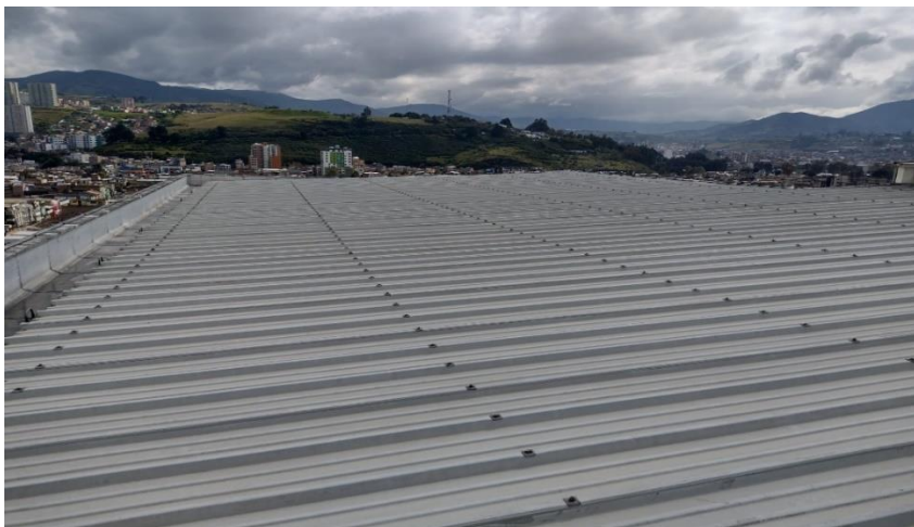
Figura 22. Cubierta Edificio San Francisco.
